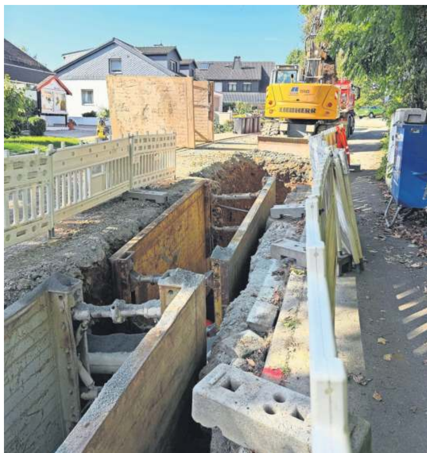
Einbau des Regenwasserkanals im unteren Teil der Bachwiesenstraße.
