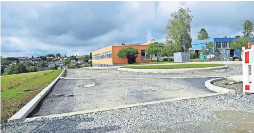
Der Wendehammer an der Grundschule ist bereits deutlich zu erkennen; die Insel ist schon begrünt.
