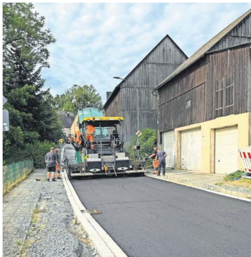
Bildunterschrift: Einbau der Asphalttragschicht in Carlsgrün.
