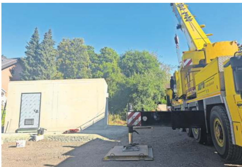
Anlieferung des Fertigteilbauwerks für die Druckerhöhungsanlage in Obersteben
