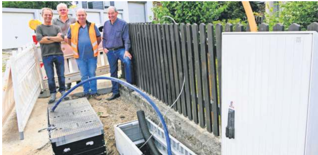
Am Standort für das Multifunktionsgehäuse in der Reitzensteiner Straße in Issigau: Bauleiter Stefan Rannersberger von der Firma Leonet, Verwaltungsleiter Uwe Jäger, Projektleiter Stephan Herold von der Baufirma Kyndos und Bürgermeister Dieter Gemeinhardt.
