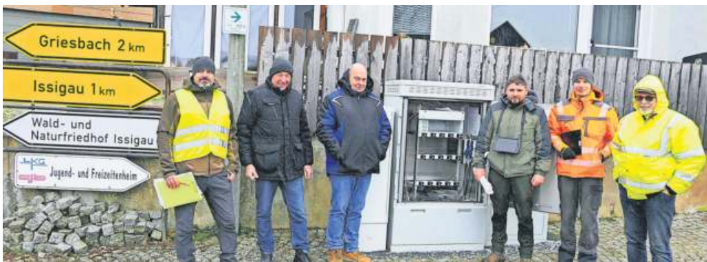
Am Glasfaserverteilkasten im Ortsteil Reitzenstein. Im Bild (von links) von der VG Lichtenberg-Issigau Torsten Gotsch, der Issigauer Bürgermeister Dieter Gemeinhardt, von der Firma Kyndos-Bau, Bauleiter Stephan Herold und Polier Paul Manic, von der Firma LuK, Carsten Bergmann und vom bayerischen Telekommunikationsunternehmen LEONET, Klaus Wittig.
