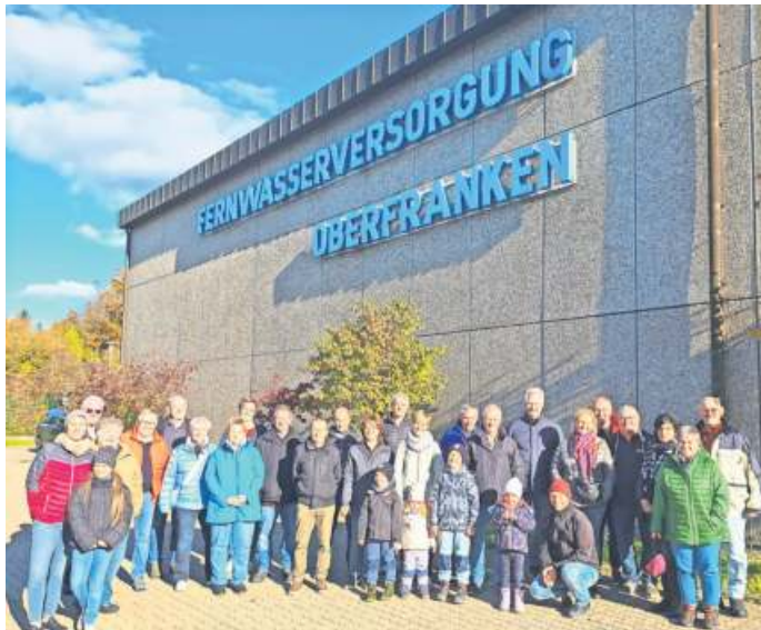
Die teilnehmenden Mitglieder der FWV-OG Dürrenwaid vor dem Betriebsgebäude der FWO-Trinkwasseraufbereitungsanlage in Rieblach. Mit im Bild FWO-Betriebsleiter Michael Vokal und Obmann Alexander Marquardt (Vierter und Fünfter von rechts).
