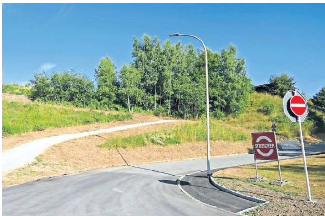
Die Stadt Naila hat eine Verbindung vom neuen Radweg für einen Einstieg in den Radweg aus Schwarzenbach a. Wald kommend über die Bogenbrücke geschaffen.
