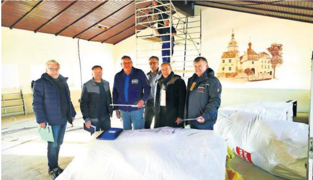
Baubesprechung im Saal des Obergeschoss. Im Bild (von links) Wernfried Zeitler, Mitarbeiter der Gemeinde Berg, Michael Schaller, Armin Vogel, Hartmut Frieser, Architekt Klaus Greim und Rainer Neubauer. Im Hintergrund von der Firma FEG Lukas Eck und Marcel Röstel.
