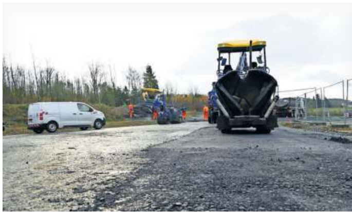
Die Tragschicht ist auf gesamter Länge von rund 1.300 Metern sowohl auf der Straße wie auch dem Radweg aufgebracht, in der kommenden Woche folgt die Deckschicht.
