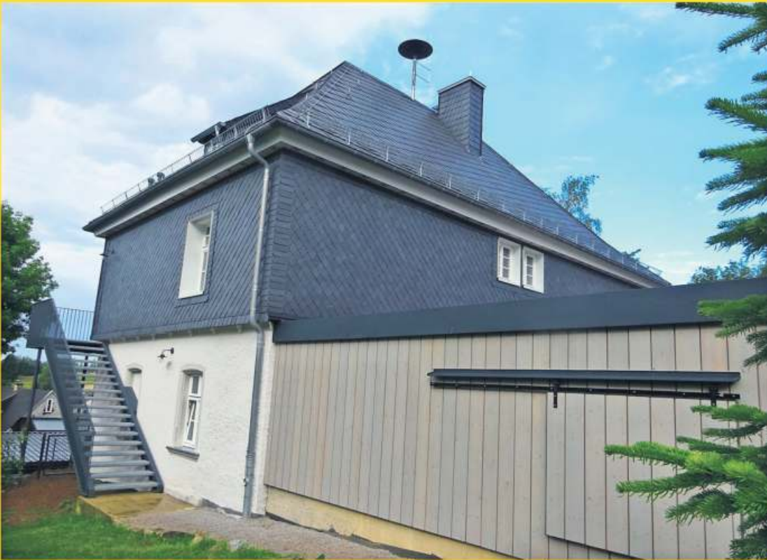
Ansicht von Osten mit Brandschutztreppe
