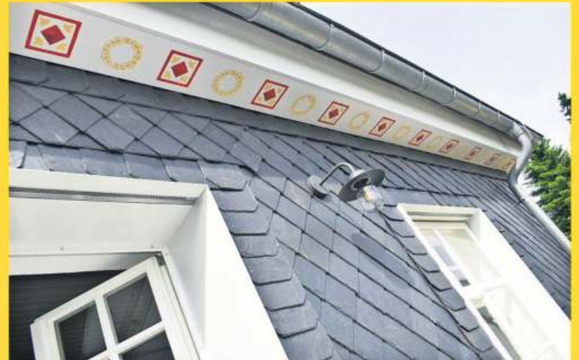
Vorgefundene Ornamente am Dachvorsprung neu angebracht
