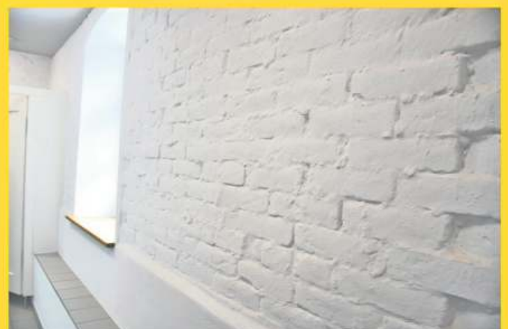
Geschlämmtes altes Mauerwerk
