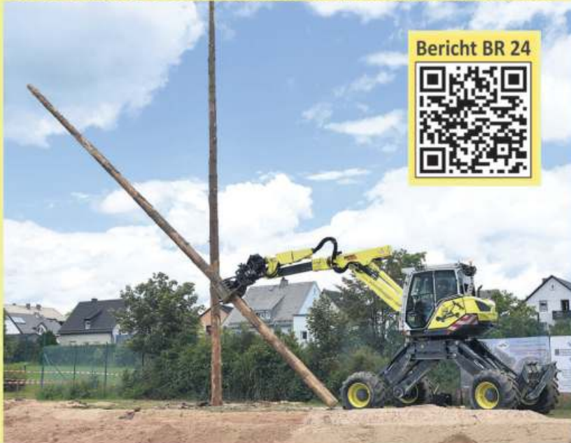
Schreitbagger Simon sorgte für den fachgerechten Einbau der 19 Meter langen Holzstämmen beim spektakulären Zielfällen
