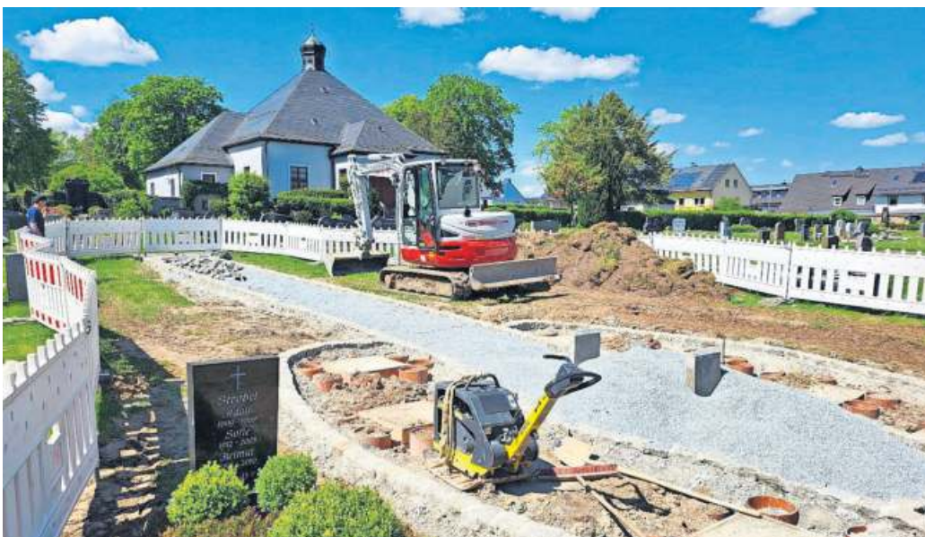
Das Bild zeigt die Baustelle der Stelenanlage und die ausführende Firma Pflasterbau Wolfrum aus Lehsten.
