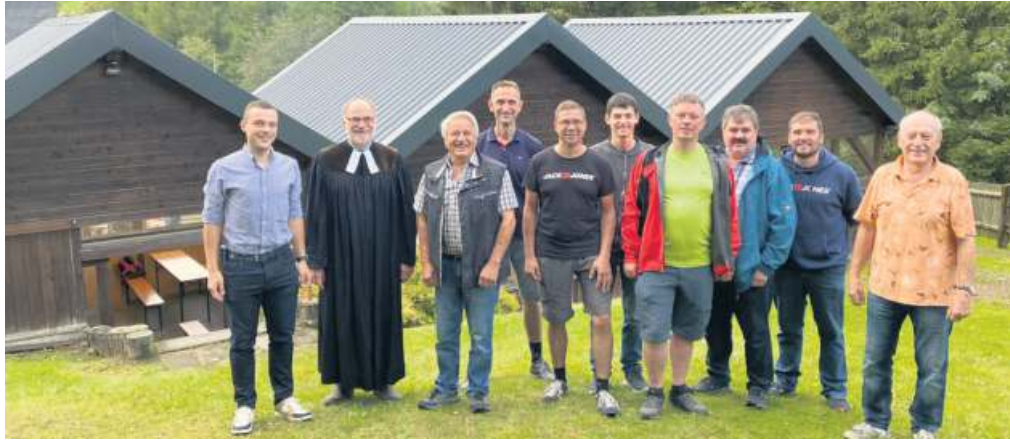
Freuten sich über das neue Dach: Maximilian Stöckl von der Gemeinde Bad Steben und Pfarrer Dirk Griebach sowie der Baurupp der Bobengrüner Ortsgruppe und einer deren Sponsoren.
