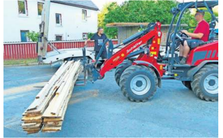
Unter anderem wird ein Zaun als Abgrenzung zur Teichanlage gebaut.
