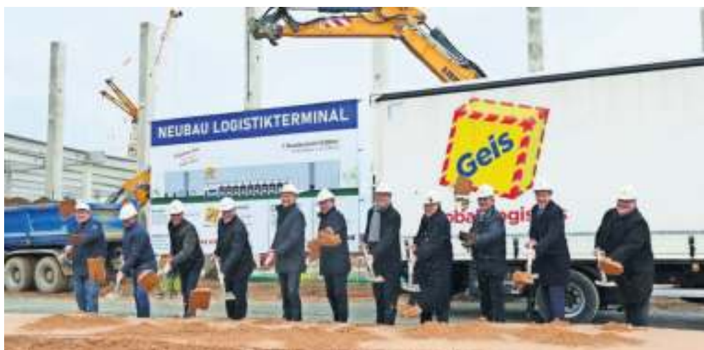
Symbolischer Spatenstich für das erste eigene Logistikterminal der Geis Bischoff Logistics im Nailaer Gewerbegebiet Kalkofen.
