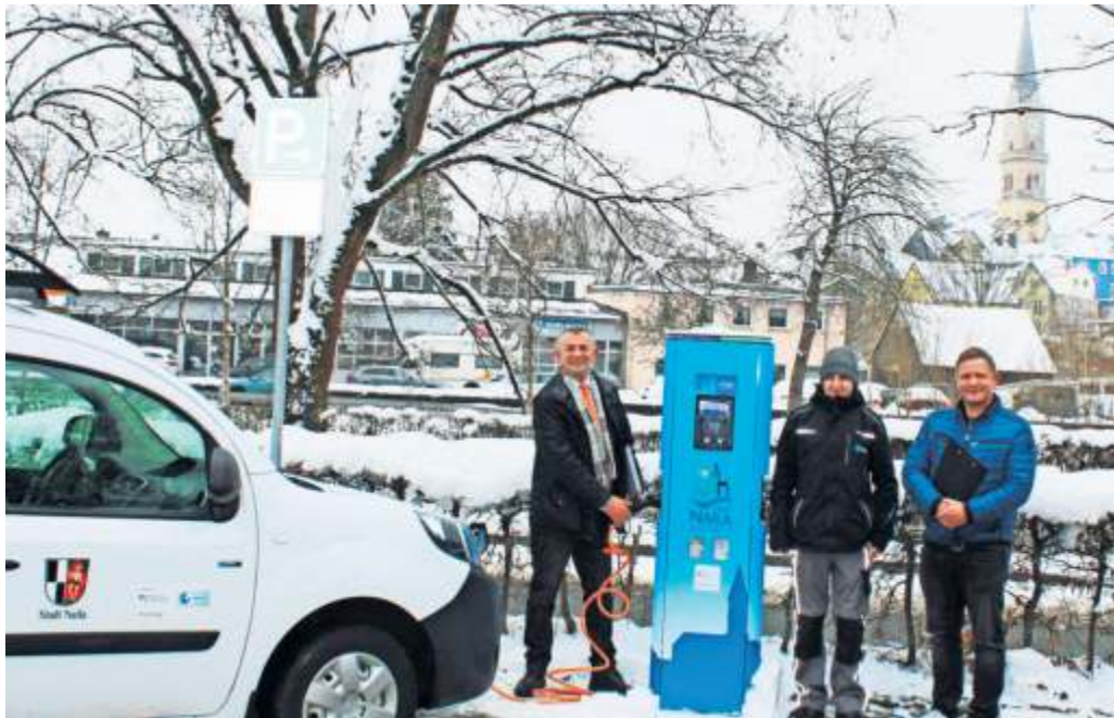
Das Foto zeigt von links: 1. Bürgermeister Frank Stumpf, Nico Zachner (Firma Mer Germany) und Sascha Eberhardt (Bauamt Stadt Naila), bei der Inbetriebnahme der Ladesäule am Bahnhof in Naila.
