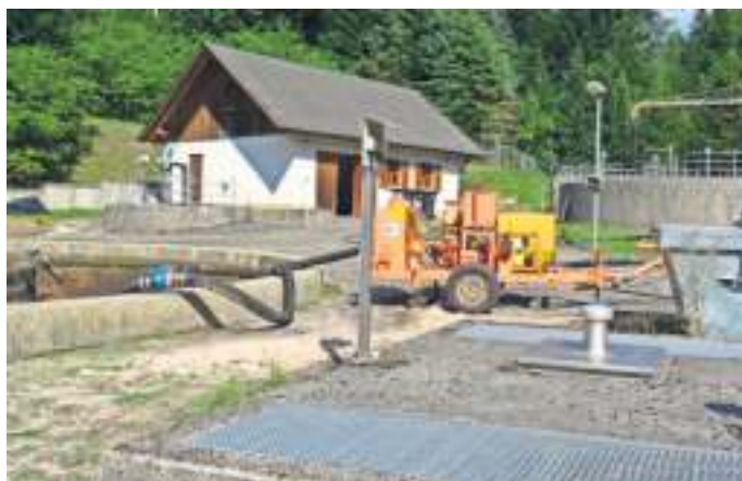
2022 wurde die Abwasseranlage Bernstein saniert.
