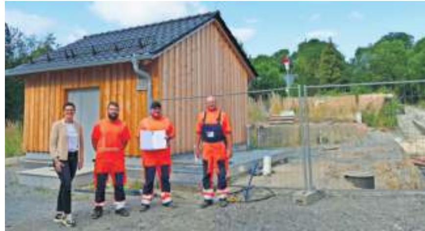
Unser Bild zeigt vor dem neuen Pumpwerk in Gottsmannsgrün (von links) Bürgermeisterin Patricia Rubner mit den Angestellten des Kommunalunternehmens Berg Ronny Köhler, Christian Ebert und Gerhard Brühnschwein.
