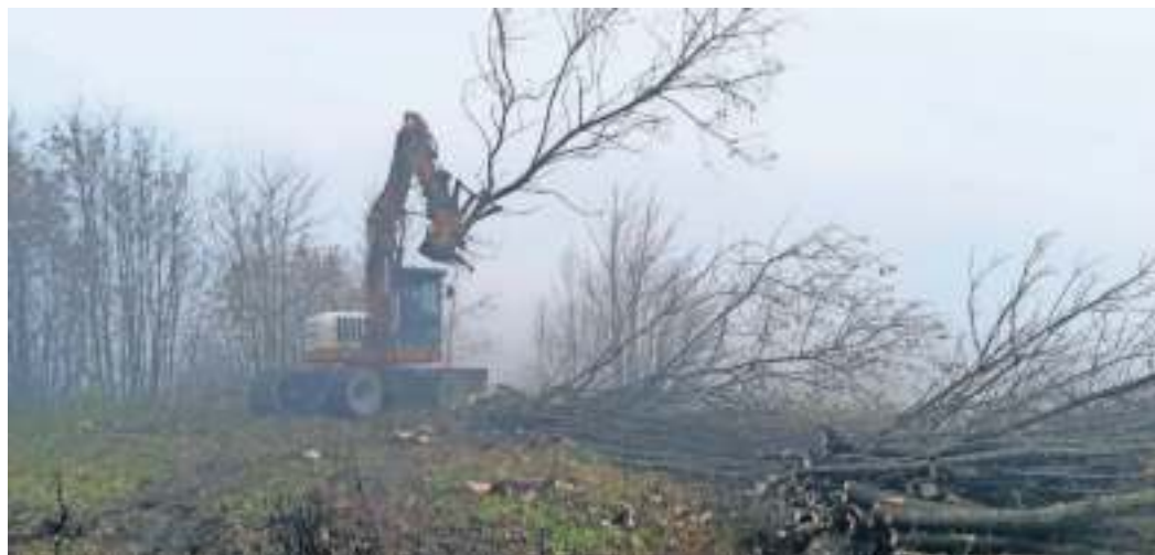
Rodungsbagger im Einsatz
