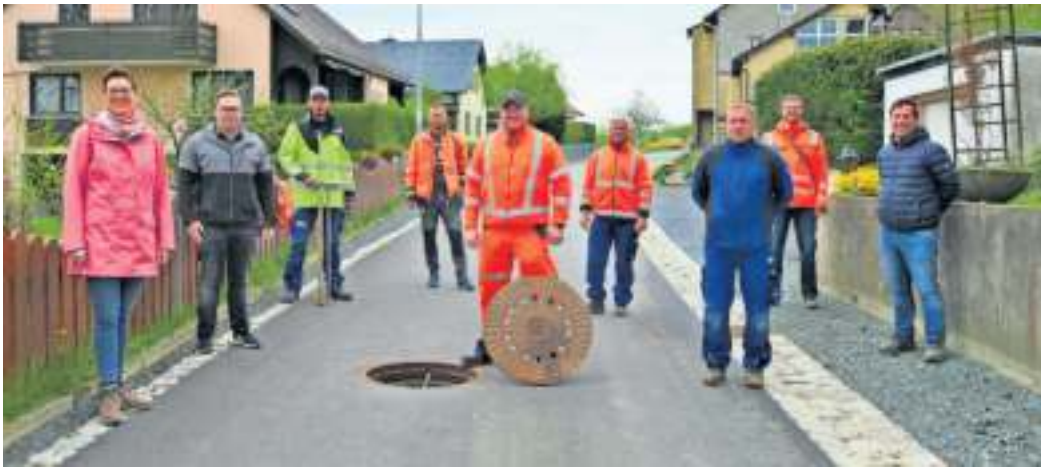
Gruppenfoto in der bereits fertig asphaltierten Steinbühler Straße (von links): Bürgermeisterin Patricia Rubner, Verwaltungsmitarbeiter Felix Korn, Wasserwart Alexander Büttner, TIW-Bauleiter Woldemar Buchmüller, Klärwärter Christian Ebert, TIW-Polier Stephan Riedel, von der Firma Südwasser René Henschel, vom Ingenieurbüro für Baumanagement Michael Schramm und Thomas Rodler, Geschäftsführer des Planungsbüros USS-Consult
