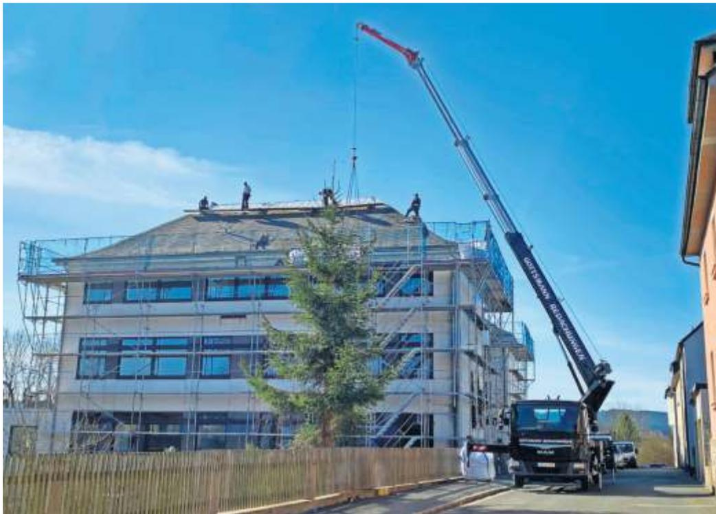
In einem ersten Bauabschnitt der erforderlichen Generalsanierung der Mittelschule Frankenwald (ehemalige Hauptschule Naila) wird derzeit die Dacheindeckung erneuert und die oberste Geschosdecke gedämmt. In die-
