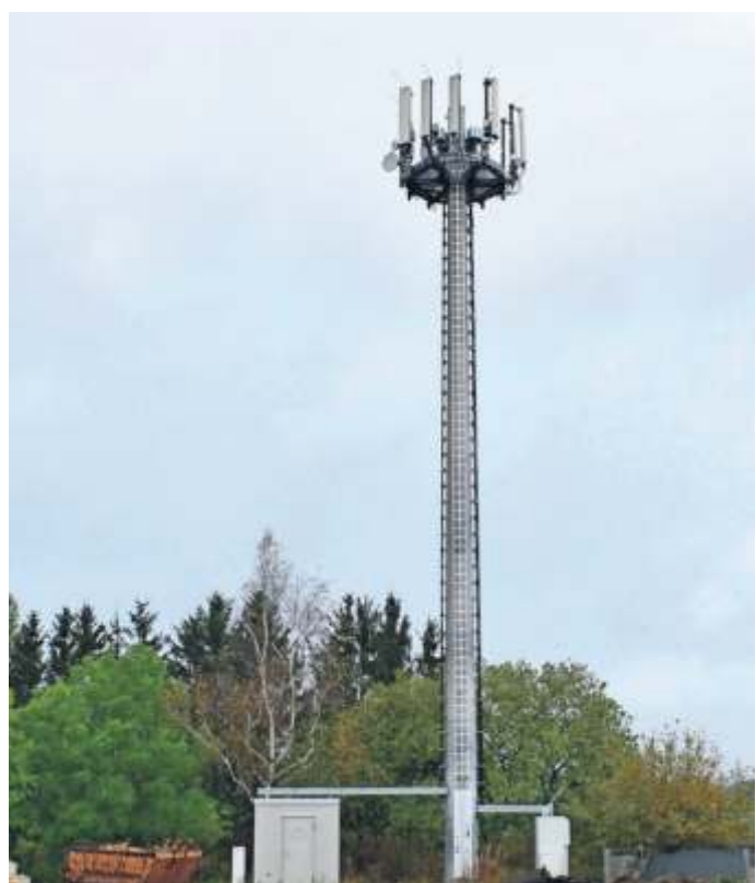
Mobilfunkmast am Stadtbauhof
