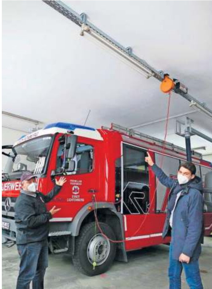
Das Foto zeigt Kommandant Daniel Sarembe (links) und Bürgermeister Kristan von Waldenfels unter der frisch sanierten Decke der Fahrzeughalle ohne Löcher und Wasserflecken.
