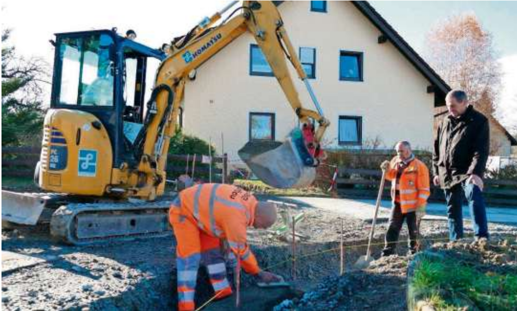
Das Foto zeigt (von links) Bürgermeister Dieter Gemeinhardt, Polier der Firma SBG Tiefbau GmbH, Andreas Lüttig sowie Mitarbeiter beim Setzen der Bordsteine in der Zollstraße.
