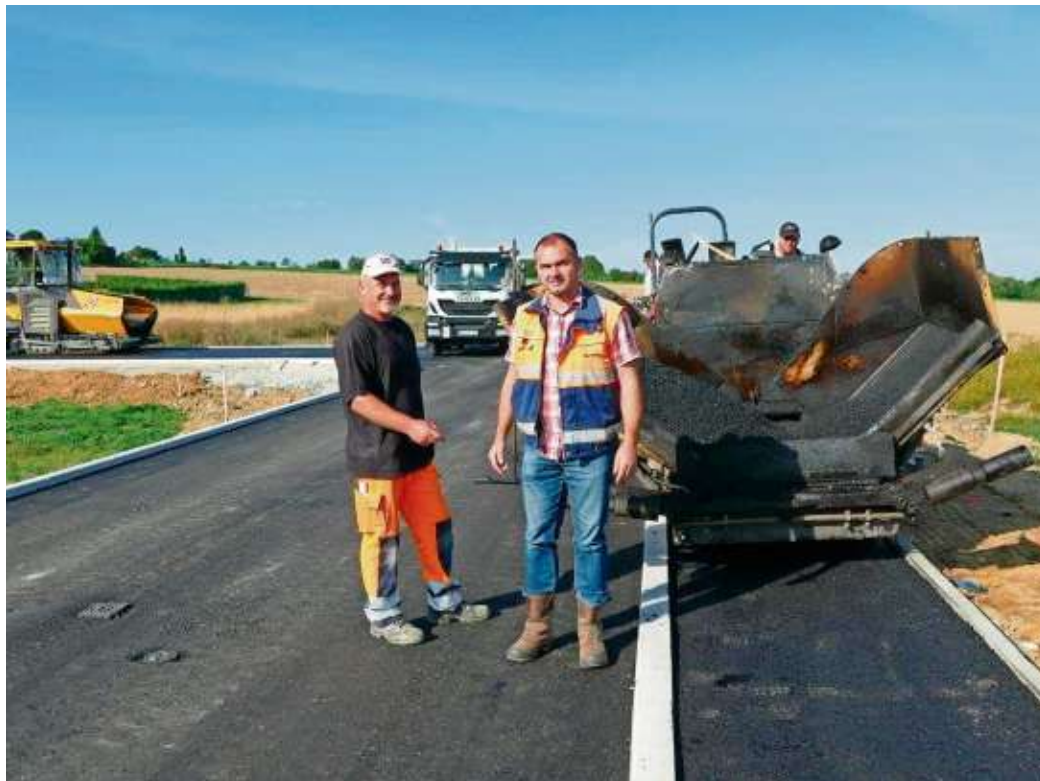
Unser Bild zeigt Polier Frank Petzold und Bauleiter Mario Mittag von der zuständigen Baufirma Streicher, Tief- und Ingenieurbau aus dem thüringischen Jena und im Hintergrund die laufenden Asphaltierungsarbeiten.
