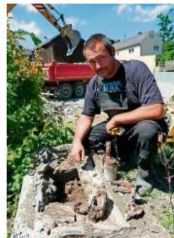
Polier Norman Spranger von der Baufirma WTU aus Weischlitz zeigt den Fund im Hohlraum des Fundamentes vom Kriegerdenkmal.
